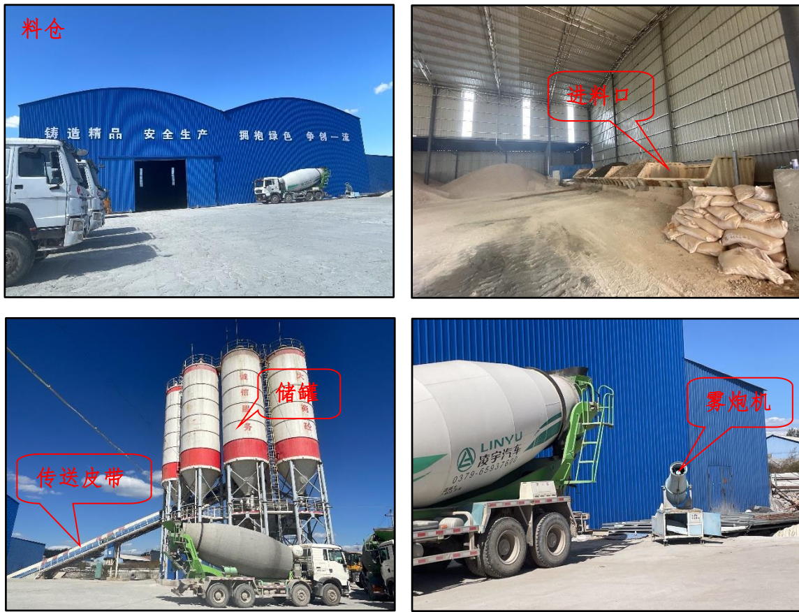
图 4-1 现场勘查情况
