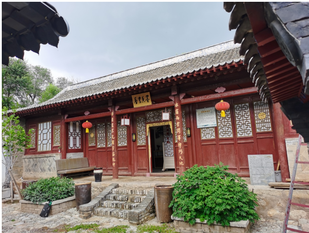
修复后老宅祖屋
