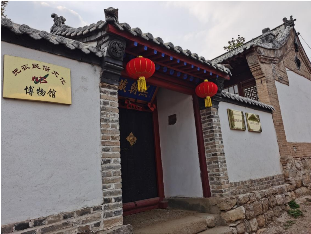
修复后老宅外貌
