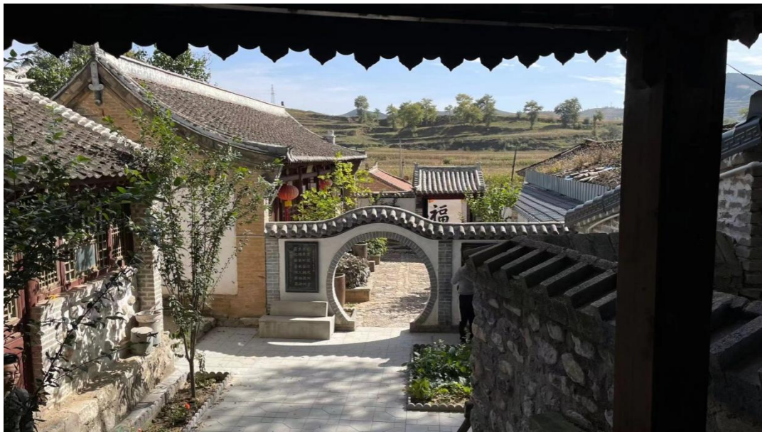
修复后祖宅庭院全貌
